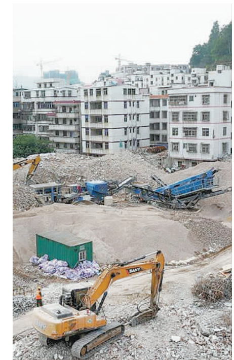
深圳罗湖“二线插花地”棚改拆迁项目，“克磊镙”工作现场。 杨阳腾摄
