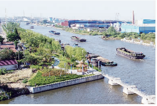
沿海“水上高速”中线航道海安船闸，船来船往。
