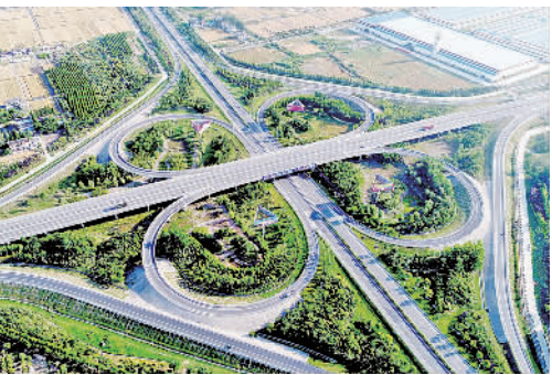
全首幅叶型328国道和204国道互通立交，气势磅礴。
