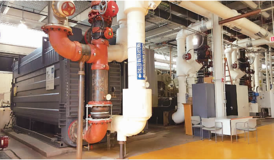
安装在新泽西罗格斯州立大学的远大余热利用非电空调。(郭 辑供图)
