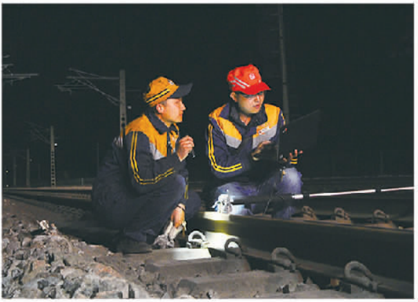
△凌晨3点，刘玉辉与同事一起检测经过打磨后的钢轨廓形。
