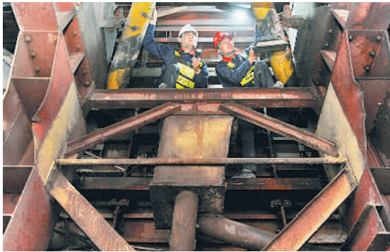
宋青波(左)检查隧道二次加固施工情况。
