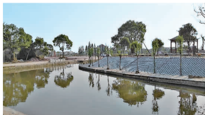
东源村正在建设的垂钓基地一角。
