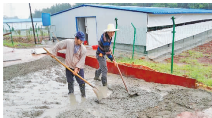
东源村村民在修建肉鸡养殖基地的消毒池。
