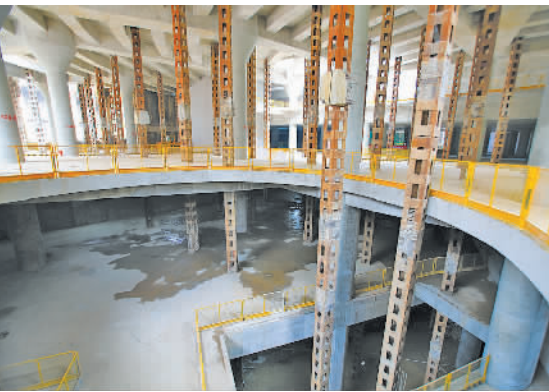
结构形式复杂的光谷综合体主体结构。
