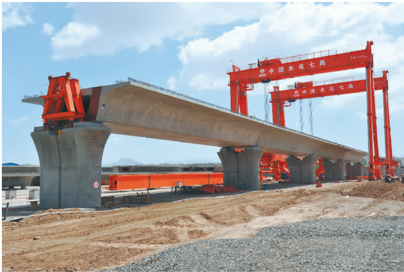
5月5日,建设中的京张高铁工程张家口宣化区境内龙洋河特大桥工地。目前,京(北京)张(张家口)高铁工程、呼(呼和浩特)张(张家口)铁路客运专线工程和张(张家口)大(大同)城际专线工程,三条线河北段工程正在紧张有序地推进,届时华北北部将形成快速客运网。 陈晓东摄
