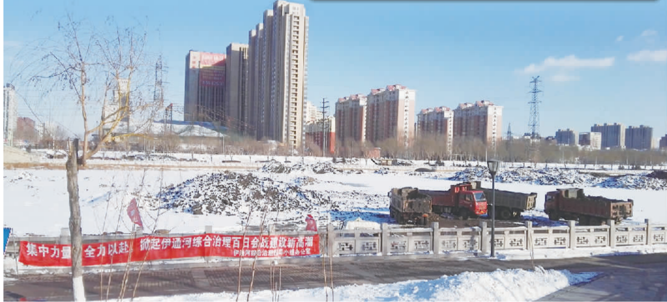
2016年入冬以来,吉林省长春市加大了伊通河综合治理力度。图为长春市区内一段淤渣施工现场。 本报记者 李万祥摄
