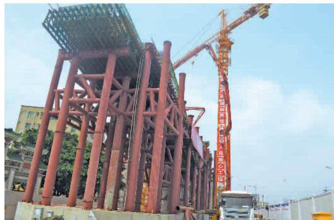
近日,由中铁航空港集团承建的深圳地铁6号线合署区间150米钢构连续梁14号主墩拱肋顺利浇筑完成,标志着深圳地铁首座150米大跨钢构连续梁正式转入连续梁上部结构施工。深圳地铁6号线建成后大大减轻深圳北站的客流压力,带动宝安区、光明新区沿线开发发展。 王亚帅摄
