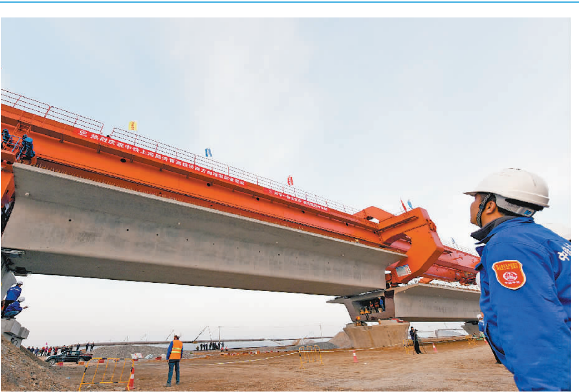
3月29日18时8分，架桥机将一榀长32米、重近900吨的箱梁平稳准确架设在潍坊特大桥桥梁支座上。至此，中铁上海工程局集团参建的济青高铁站济南方向箱梁架设顺利完成。据了解，济青高铁正线全长307.9公里，设计速度350公里/小时，总投资600亿元，是我国第一条由地方为主投资建设的高速铁路项目。 张华先摄
