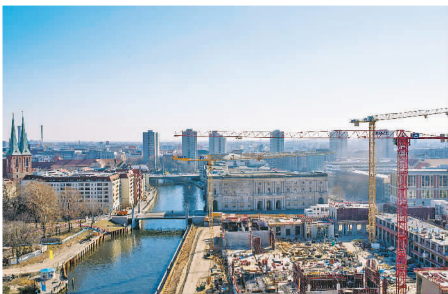
图为柏林市中心多个地方在施工。
