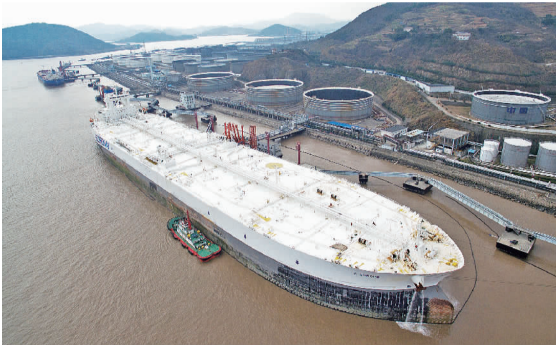
宁波舟山港大榭港区兴华二期45万吨原油码头于2012年5月正式投产,为亚洲最大、中国首个正式投用的45万吨原油码头。图为世界在航的最大载重吨级别船舶(超巨型原油轮)“泰欧”号在该港完成卸油后离泊。新华社记者 黄宗治摄
