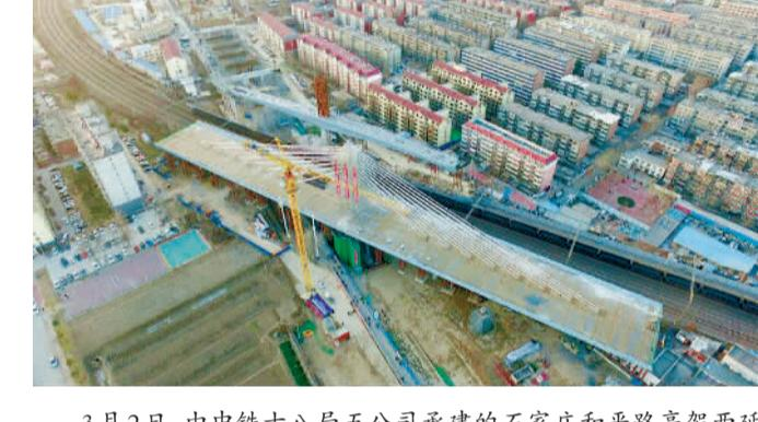
3月2日，由中铁十八局五公司承建的石家庄和平路高架西延跨石太铁路转体主桥及转体匝道钢梁，沿顺时针旋转，实现精准就位。该主桥转体长242.6米，创造了新的世界纪录。 龙 毅摄
