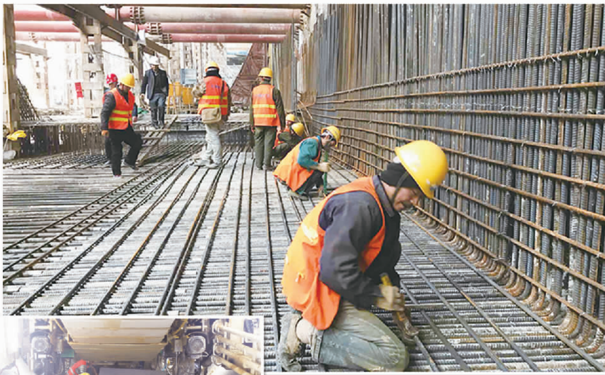
上图 徐州地铁3号线车站主体结构的施工工人正在进行钢筋绑扎。(资料图片)
