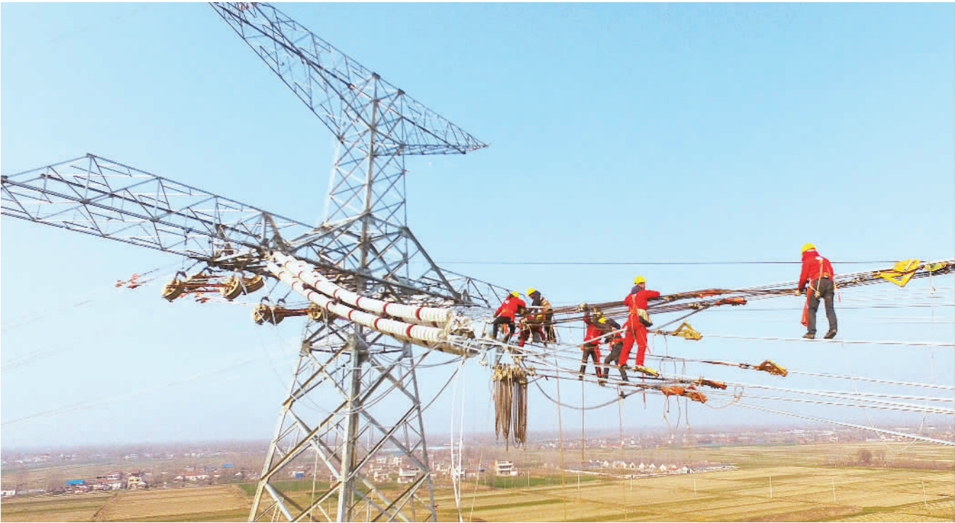
2月24日，在江苏阜宁县益林镇境内工程施工人员跨越新(沂)至长(兴)铁路架线。当日，锡盟—泰州±800千伏特高压直流输电线路工程顺利跨越新长铁路。该工程是国家大气污染防治行动计划“四交四直”工程其中之一，建成投运后，每年将向江苏输送电量550亿千瓦时，相当输送煤量2520万吨，可减少排放二氧化碳4950万吨，有力促进长江三角区域大气污染防治。 汤德宏摄
