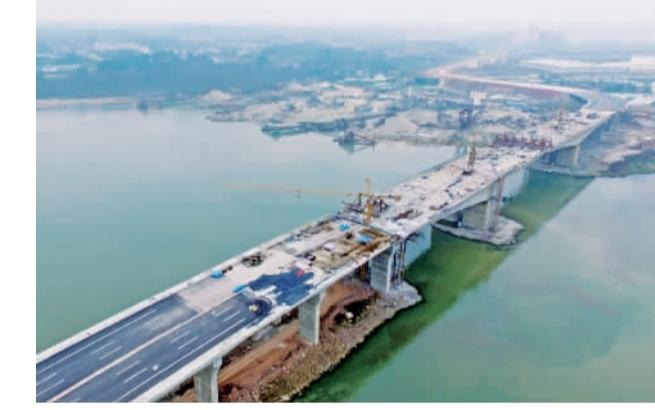
2月13日，四川遂宁涪江五桥引桥主体结构全部完成，主桥右侧顺利合龙，目前正在左侧合龙作业。预计全桥将于今年3月底完成合龙，5月底完成附属工程，达到通车条件。
