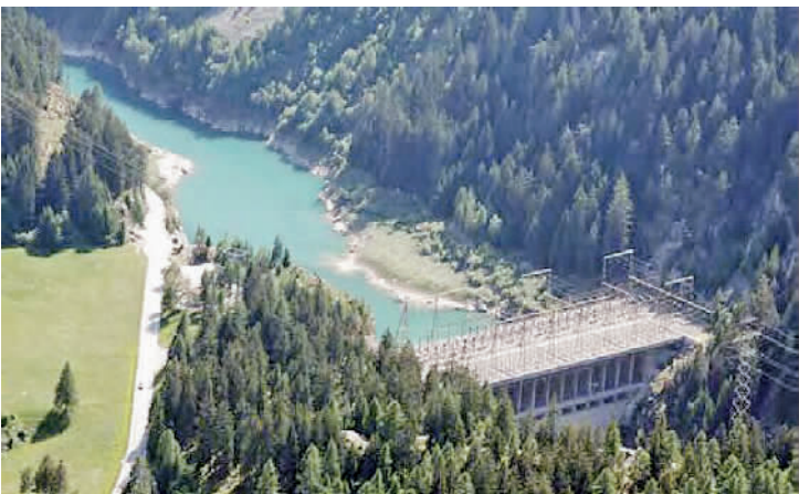
俯瞰林塔尔水电站
