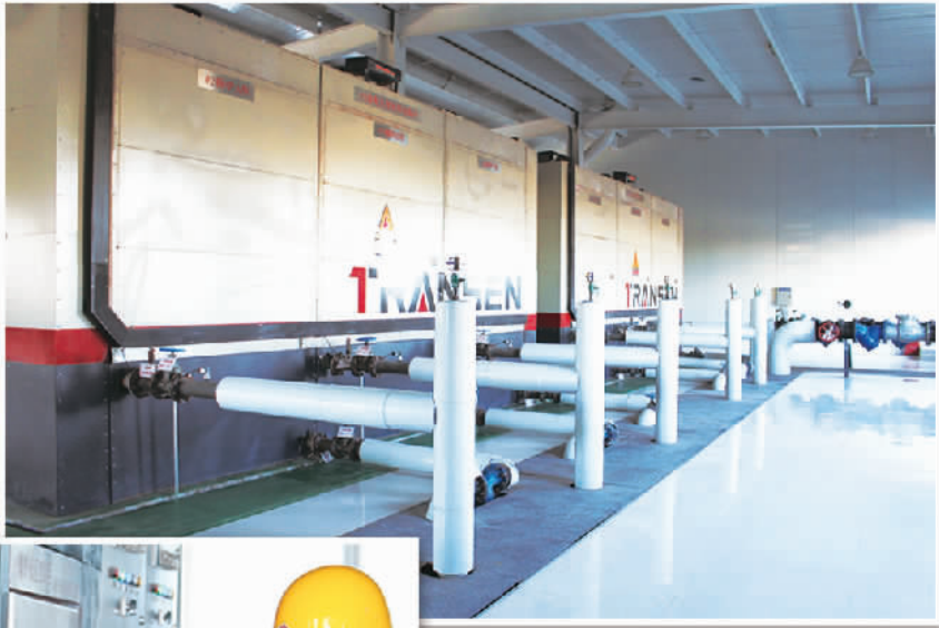
左图 内蒙古通辽扎鲁特旗河北新区风电供热站的高电压固体蓄热锅炉。
