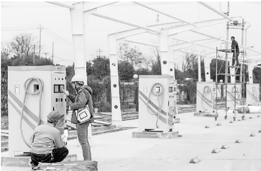
近日,江苏泰州市为公交汽车交流充电桩进行投运前调试。国家电网计划到2020年建成充电站1万座、充电桩12万个。 本报记者 翟天雷摄
