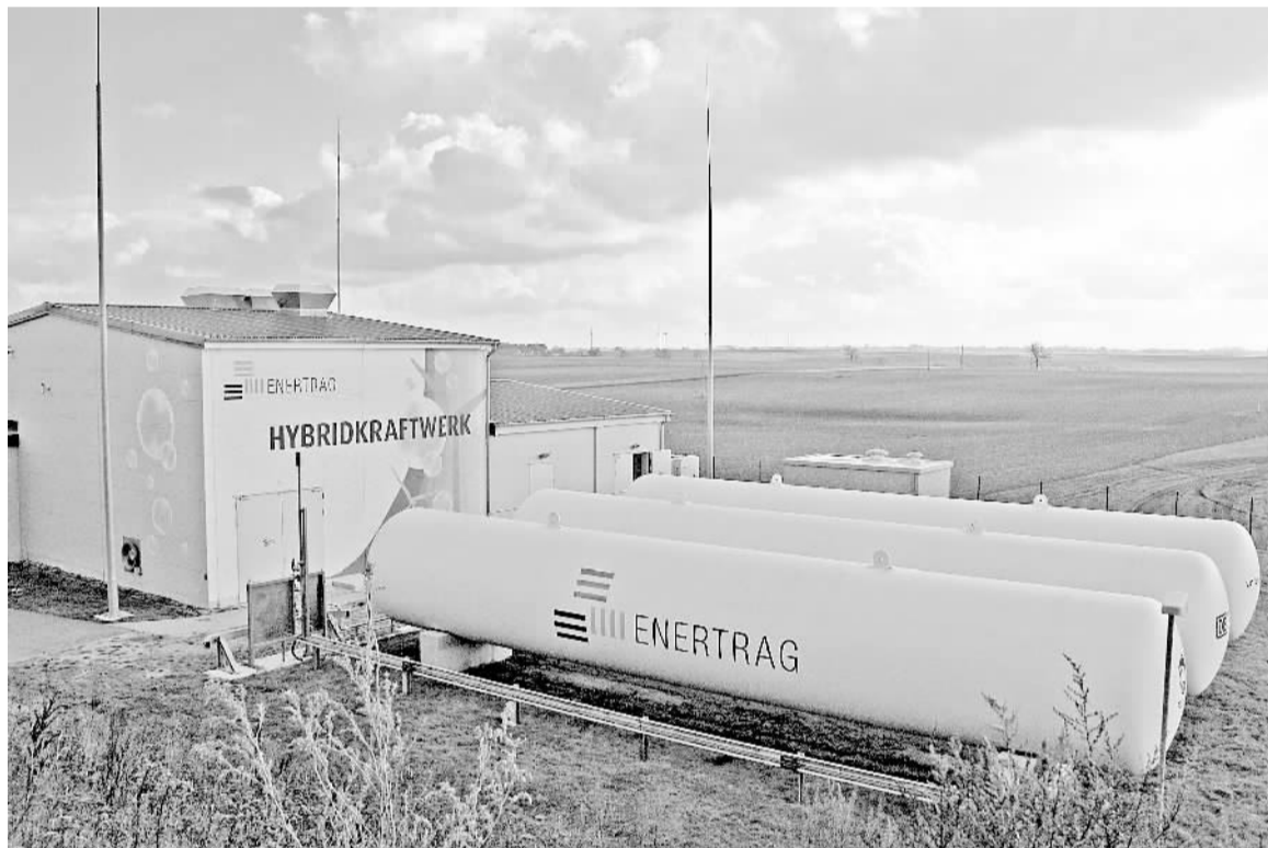
德国勃兰登堡州一座用氢能作为电力存储介质的混合能源试点电站。这座电站主体建筑由一座氢能电解槽和一座生物质能电站组成。电站不远处伫立着大型风电机组,单机容量最大可达2兆瓦,产生的电力既可以直接接入电力输送网,又可以用于电站的电解制氢反应。
