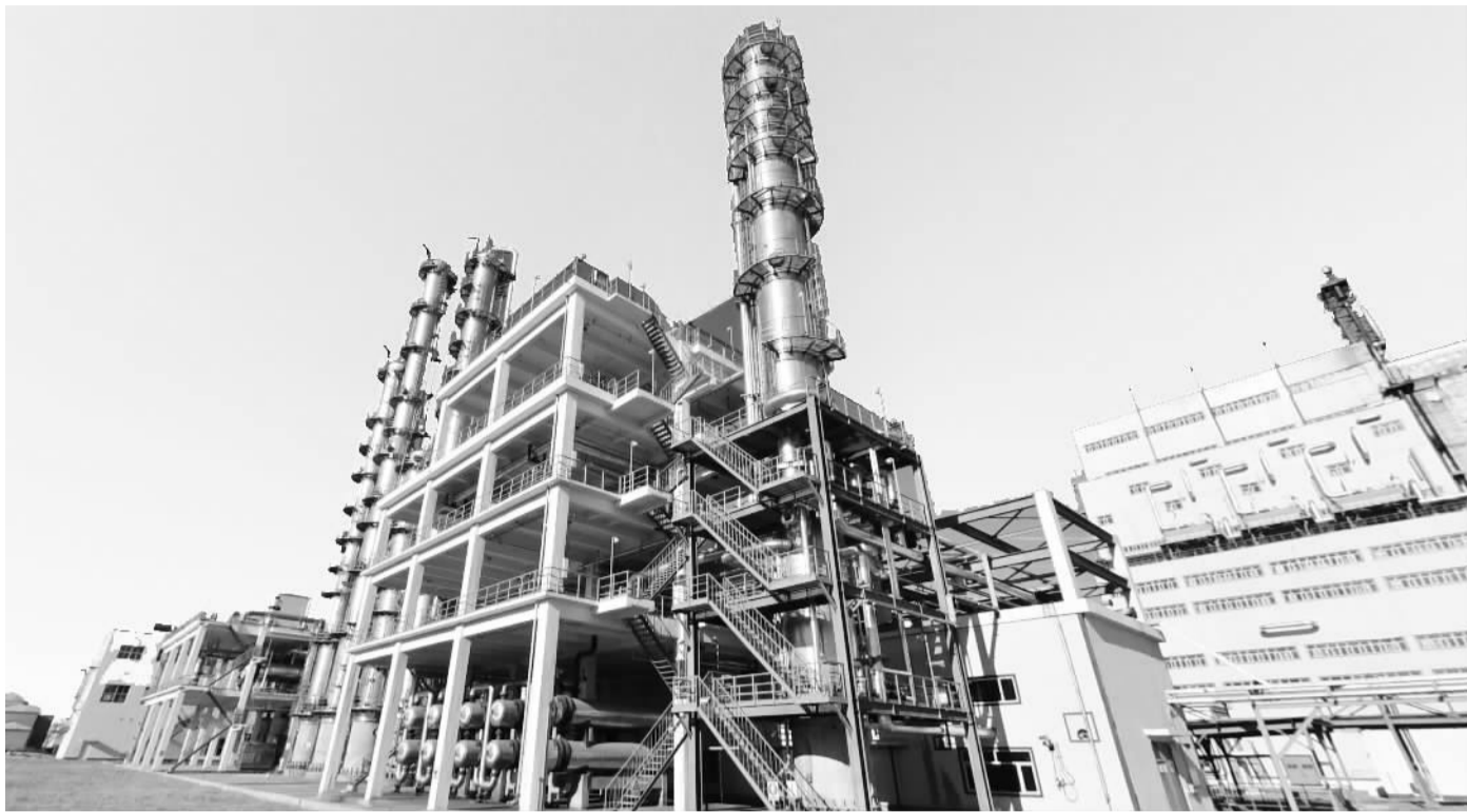
这是双鸭山市龙煤天泰煤制10万吨芳烃项目现场(11月9日摄)。今年以来,黑龙江双鸭山在经历低谷后终于实现了财政收入正增长。在东北经济下行压力增大背景下,这座老煤城实现“逆生长”,释放出老工业基地艰难转型的积极信号。 新华社记者 王松摄
