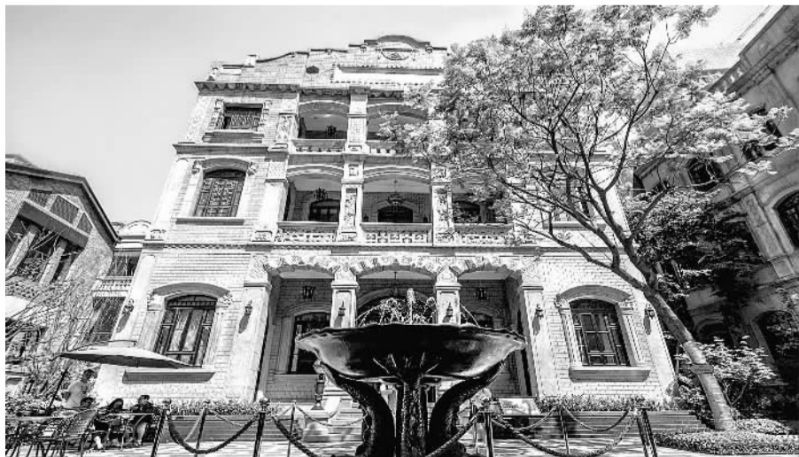
经过修缮后的重庆药材公会旧址。
