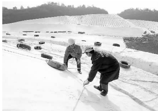
位于江西乐安县整溪溪大元村的城市生活垃圾填埋场正加紧建设即将竣工投入使用。该项目建成后，可日处理生活垃圾165吨，垃圾渗滤液100吨，将成为该县首个符合国家卫生标准的山谷型垃圾填埋场。
