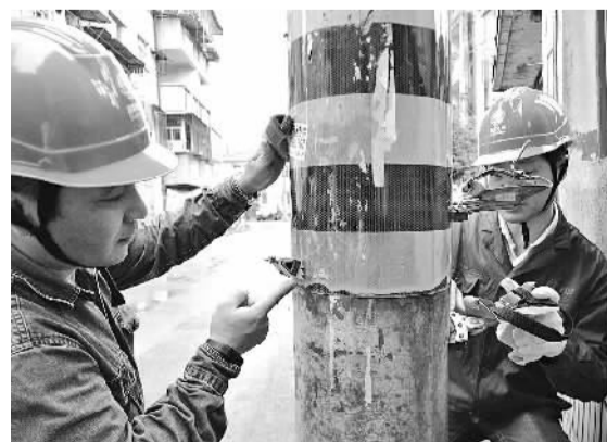
随着城郊电网升级改造不断推进，居民用电越来越方便，但若操作不当容易出现主干线烧断等情况。浙江余姚市供电公司鼓励员工进行技术改良，增加防滑齿、防坠落脚带等设备，既保障一线员工攀爬电杆安全操作，同时进一步提升供电的可靠性。图为该公司泗门供电所员工进行现场检修。 陈振初摄
