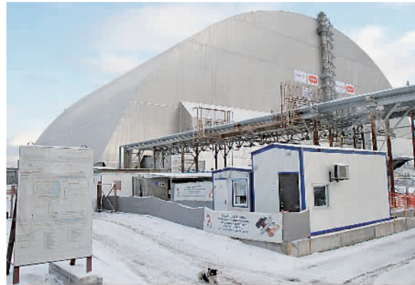
11月29日,在乌克兰基辅附近,切尔诺贝利核电站新掩体正式竣工,将4号机组反应堆罩住。乌克兰总统波罗申科出席竣工仪式时表示,新掩体的建成在人类和平利用核能、消除核污染领域具有历史意义。
