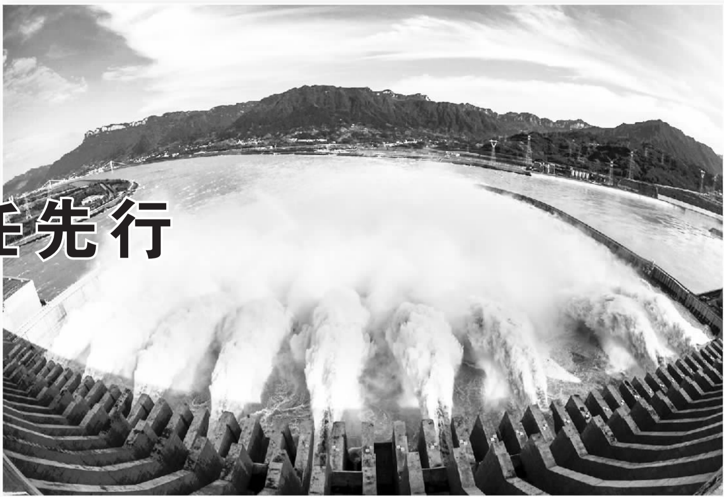
图为三峡水利枢纽工程泄洪。 郑斌摄
