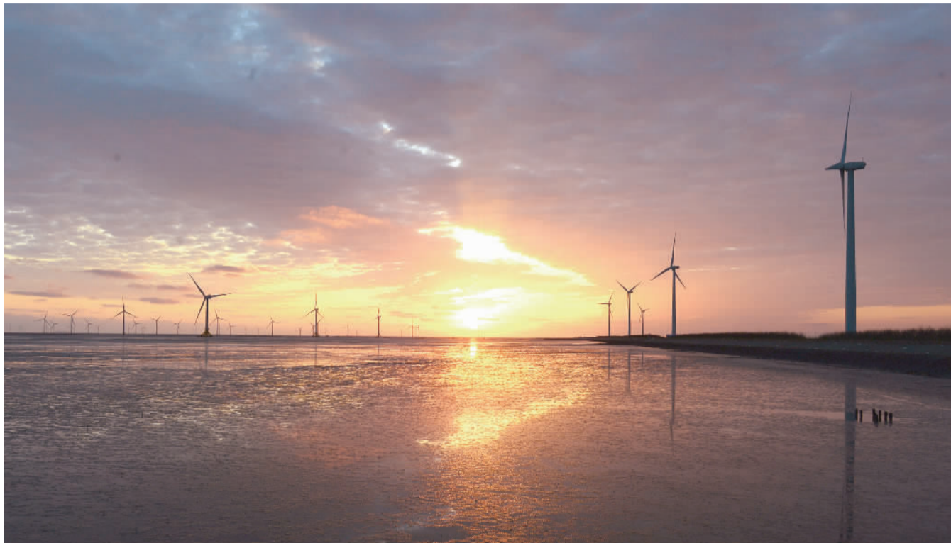
近年来,在绿色金融助力下,多地绿色发展步伐稳健。这是11月16日拍摄的江苏南通如东风电场。江苏南通全力推动沿海风电产业、海洋高端装备产业、海洋生物产业向中高端迈进,构建现代渔业产业体系,并向绿色化转型。李存根摄(新华社发)
