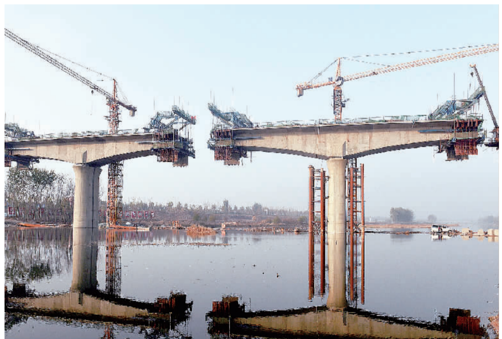
11月16日,我国第一条以地方为主投资建设的高速铁路项目——济青高铁项目架梁作业施工现场。中铁上海工程局集团济青高铁项目部承担了济青高铁潍坊特大桥23公里施工建设任务,有连续梁7处,目前已经合龙5处,其余2处预计本月全部合龙。张华先摄
