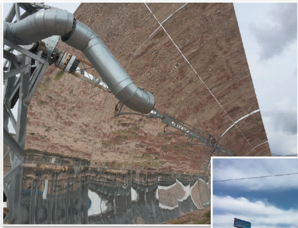
左图 随着中广核德令哈50兆瓦光热发电项目开工，其前期小规模槽式试验电站已经停运。
