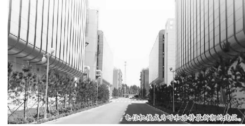
电信大楼成为呼和浩特最新潮的建筑。
