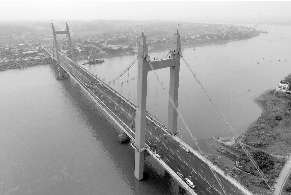
湖南第二座自锚式悬索桥——株洲枫溪大桥即将通车投入使用。据介绍,株洲枫溪大桥全长1729.4米,桥梁部分长为1429米,设计车速50公里/小时。
