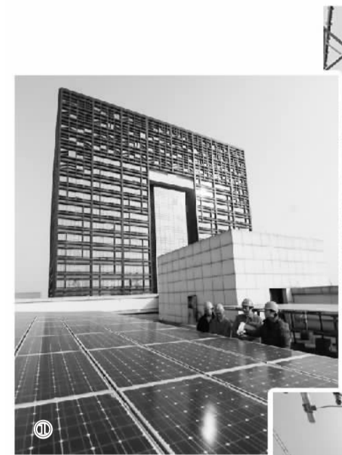
图① 国网湖州供电公司工作人员检查屋顶光伏发电装置，做好并网前期准备。
