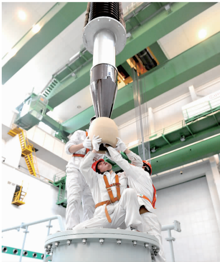
新疆特变电工股份有限公司工人在组装变压器。 本报记者 乔文汇报
