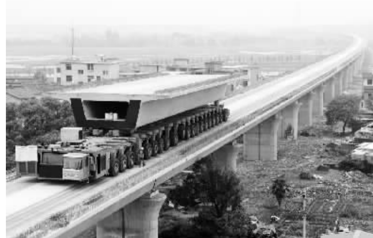
建行发挥自身传统优势，大力支持基础设施和重点项目，为中国(福建)自贸区和“一带一路”建设提升吸引力与辐射力提供有力支撑。图为建行支持建设的合福铁路(闽赣段)丰溪河特大桥施工现场。开通后的合肥至福州，最快旅行时间由原来的12小时压缩至3小时38分。
