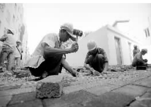
↑ 工人正在铺设透水砖。 ↓ 工人展示透水结构的雨水下渗功能。
