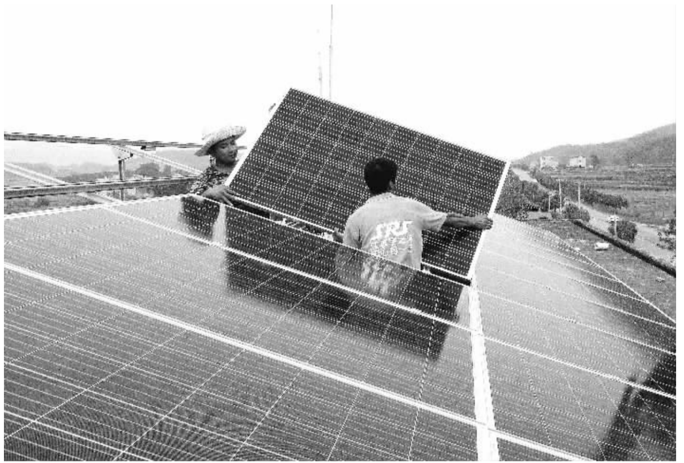
9月26日,江西安福县洋溪镇视田村李生全正忙着安装光伏电池板。近日,该县洋溪镇整合部门资金40万元在三个贫困村实施50个千瓦的光伏扶贫项目,优先扶持无劳动能力的贫困户脱贫,预计每年每户可增收1000元左右,惠及40户贫困户。 肖春根摄
