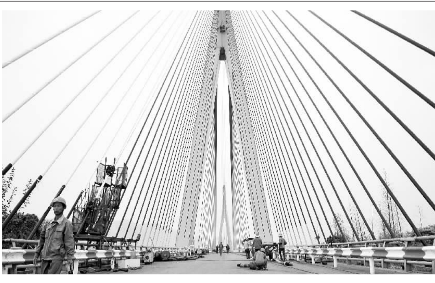
9月17日，工人们在湖北十堰市郟阳汉江公路大桥上加固更换“斜拉索”。预计11月底将完成全桥“斜拉索”更换。
