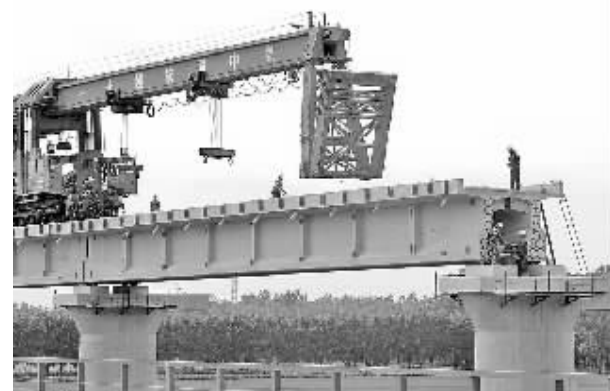
8月16日,江苏连云港市连盐铁路海州站前三标段施工现场,一台架桥机在进行铺轨作业。连盐铁路是国家中长期铁路网规划项目之一,设计时速200公里,投资额约260亿元,其正线全长234公里。 耿玉和摄
