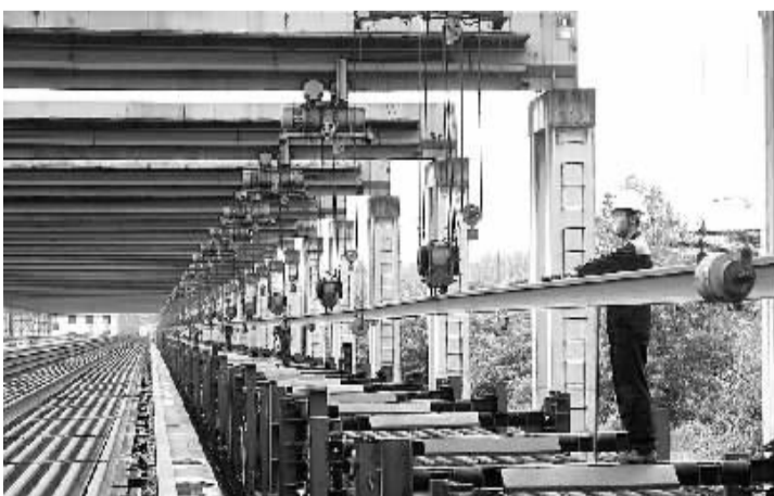
芜湖北焊轨基地,焊接好的长钢轨正在向全国各地发运。
