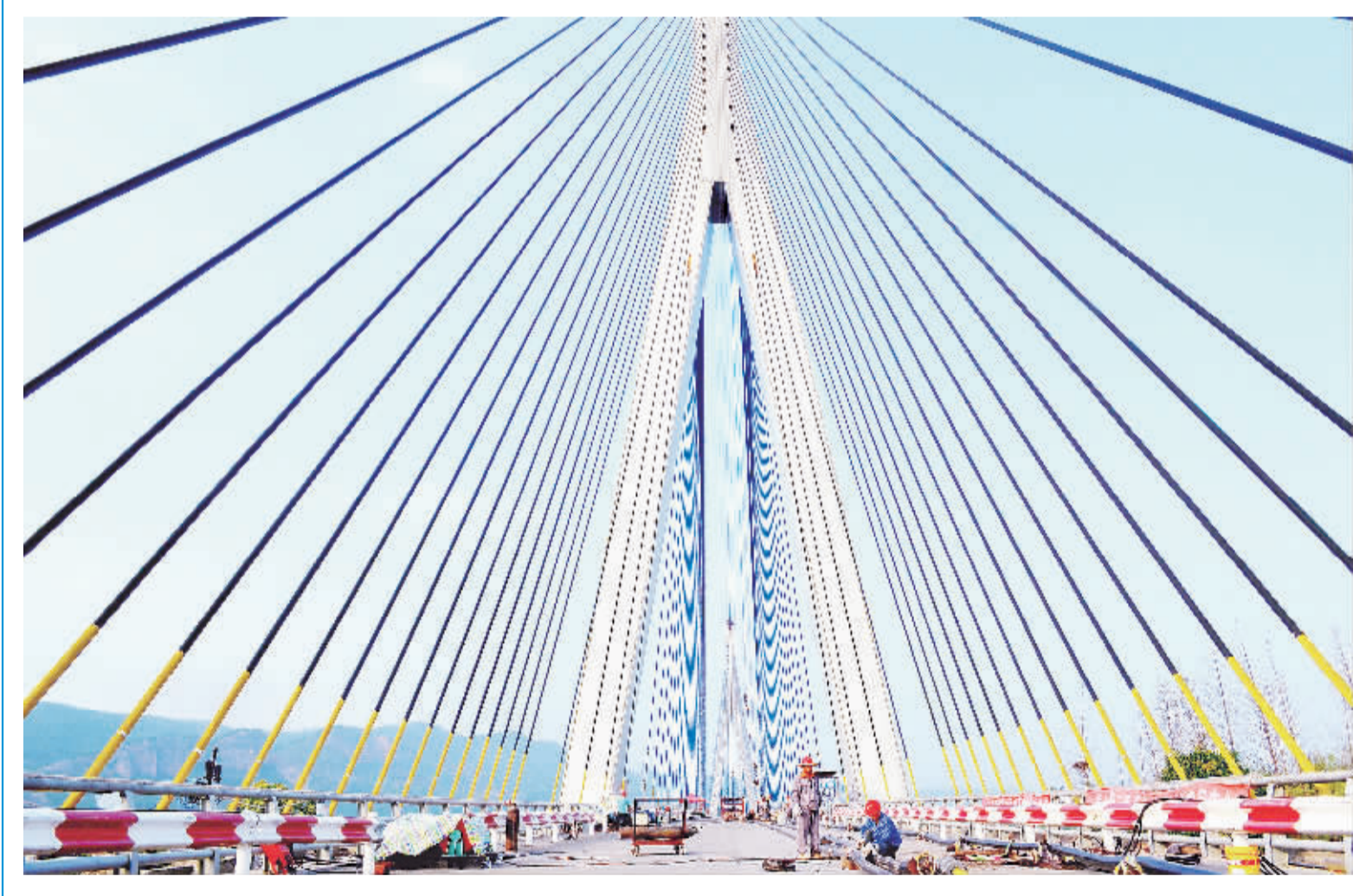
8月14日,工人正冒着酷暑高温加紧为湖北十堰郑汉江公路大桥更换斜拉索。该桥是我国首座设计建设的主跨400米以上特大跨径的、同期亚洲第一、世界第二跨度的地锚式预应力混凝土斜拉桥,在“服役”22年后,实施全桥更换斜拉索,目前已更换斜拉索44根,预计今年年底前可完成全桥更换。杨显有摄
