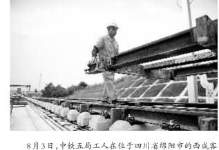
专四川段杨家堰特大桥上施工。目前,西(安)成(都)铁路 客运专线四川段正加紧建设,全段仅剩一座隧道尚未贯通, 预计今年9月底将进入铺轨阶段。西成客运专线是我国首 条穿越秦岭的高速铁路,设计时速为250公里。
