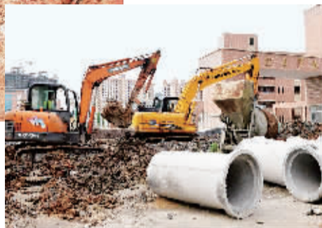
下图 7月14日,工人在江西省分宜县北环东路开挖沟渠埋设雨水管道。该县以实施“雨污分离”改造工程为契机,通过增大雨水管道排水容量、“见缝插针”植绿护绿等方式提高城市排水抗汛能力。潘卫摄
