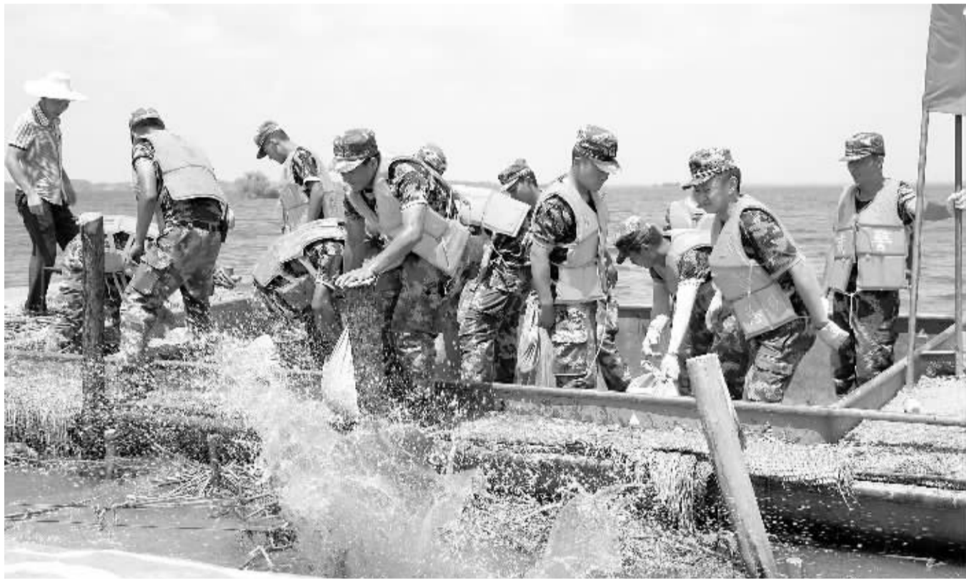
7月21日,武警安徽总队安庆支队抗洪官兵在搬运沙袋。当日,安徽安庆市望江县雷池乡武昌湖西联圩出现圩堤渗漏。武警安徽总队安庆支队官兵经过近3个小时的奋战,基本完成封堵任务。 刘仕琪摄
