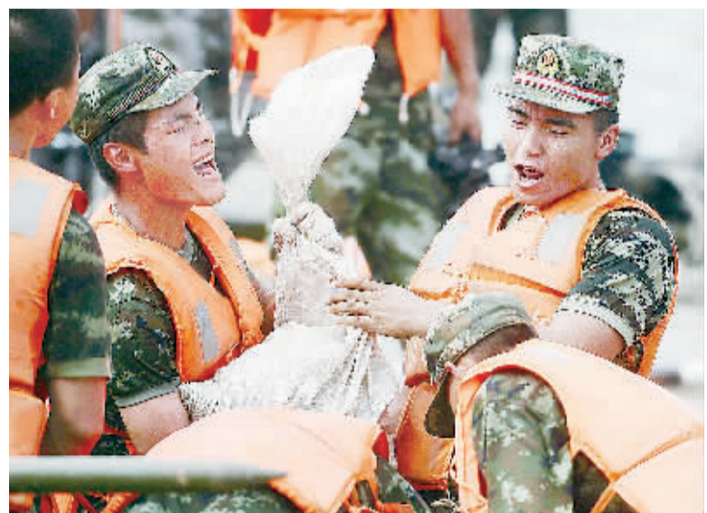
7月12日,部队战士在搬运沙袋。当日8时多,经过近两天的抢险封堵,湖南华容新华垸溃口成功合龙。在这一场抗洪攻坚战中,冲在最前线的是抢险部队的官兵,他们日夜奋战,用钢铁之躯抵御洪流,保护着一方百姓的生命财产安全。
