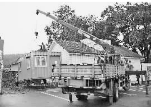
有关部门在拆除路边的违章建筑。
