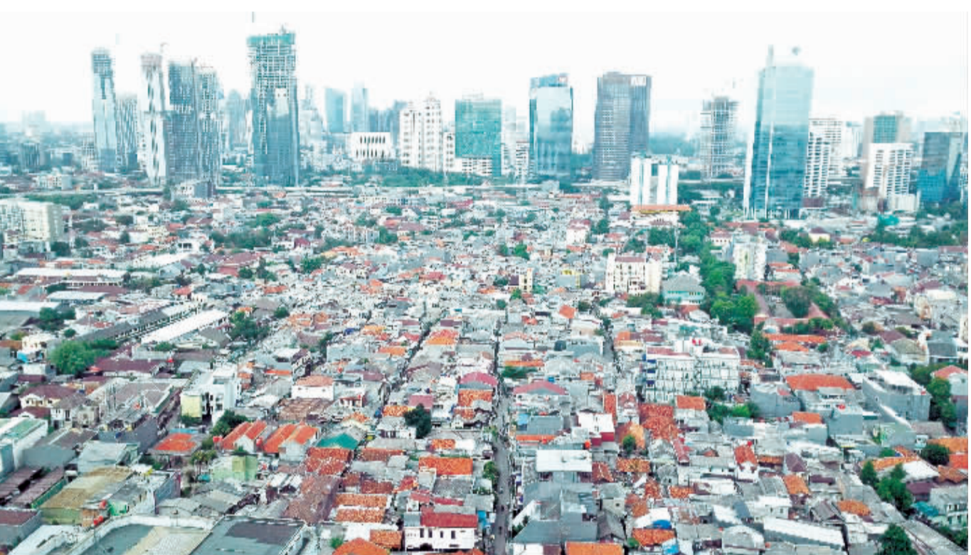
本届印尼政府期望能突破基建瓶颈，并将之作为刺激经济复苏的主要动力。印尼许多城市希望吸引更多中资企业前来投资开发、共同建设，尤其是高铁轻轨、高速公路、交通枢纽、机场配套、大型场馆、城市公园和城市电力系统基建领域。图为印尼首都雅加达摩天大楼与低矮平房毗邻错落的景象，贯穿该地区的地铁等基建工程正在加紧施工。
