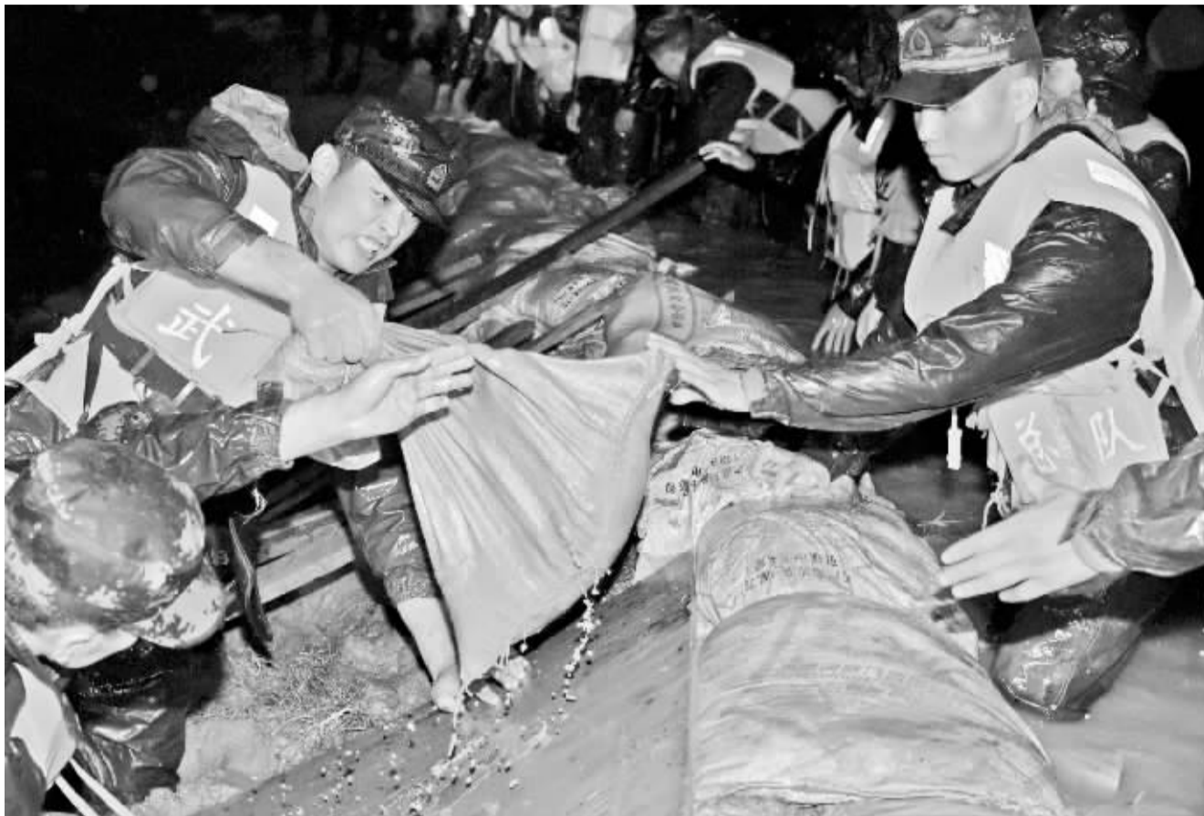
连日来,安徽巢湖地区出现暴雨天气,巢湖支流大闸湖起出警戒水位引发洪水,巢湖市半汤街道东湖村一处200米的堤坝出现50米的决口。接到险情后,武警安徽总队第二支队紧急出动奔赴现场,封堵决口堤坝,加固河堤,经过武警官兵连续5小时奋战,决口堤坝被成功堵住。图为7月1日晚,武警安徽总队第二支队官兵在封堵决口堤坝。
