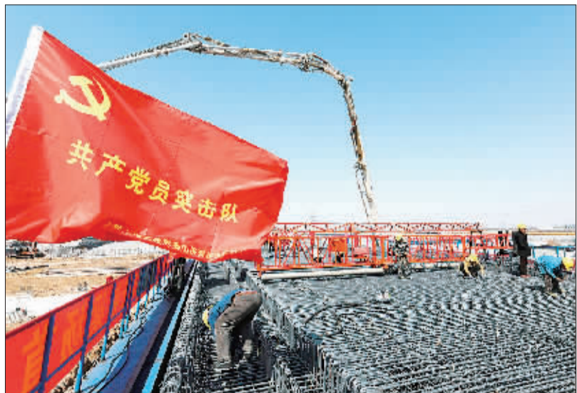
► 中铁上海工程局集团济青高铁项目部施工现场，共产党员践行“两学一做”，顽强拼搏，昼夜奋战，以优异的成绩喜迎党的生日。 张华先摄
