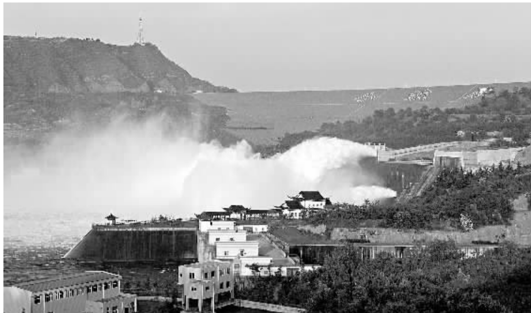
图为小浪底水库调水时形成的瀑布。水沙不平衡是黄河下游河道淤积的主要原因。从2006年起,利用黄河小浪底水库的调水调沙,济源、洛阳两地轮流承办小浪底观瀑活动。活动期间,将根据汛情、天气和黄河整体水情调水调沙。
