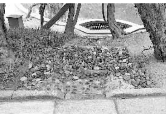
▲ 经过新增雨水过滤设施，雨水中的杂质、树叶、泥土、油污得到过滤净化之后入湖。
