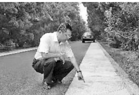
▲ 市南区城市管理局市政科负责人梁舰向记者介绍用栈桥大修时留下的废旧花岗岩板材铺就的石板路，让老青岛的文化记忆在“海绵路”上保留。
